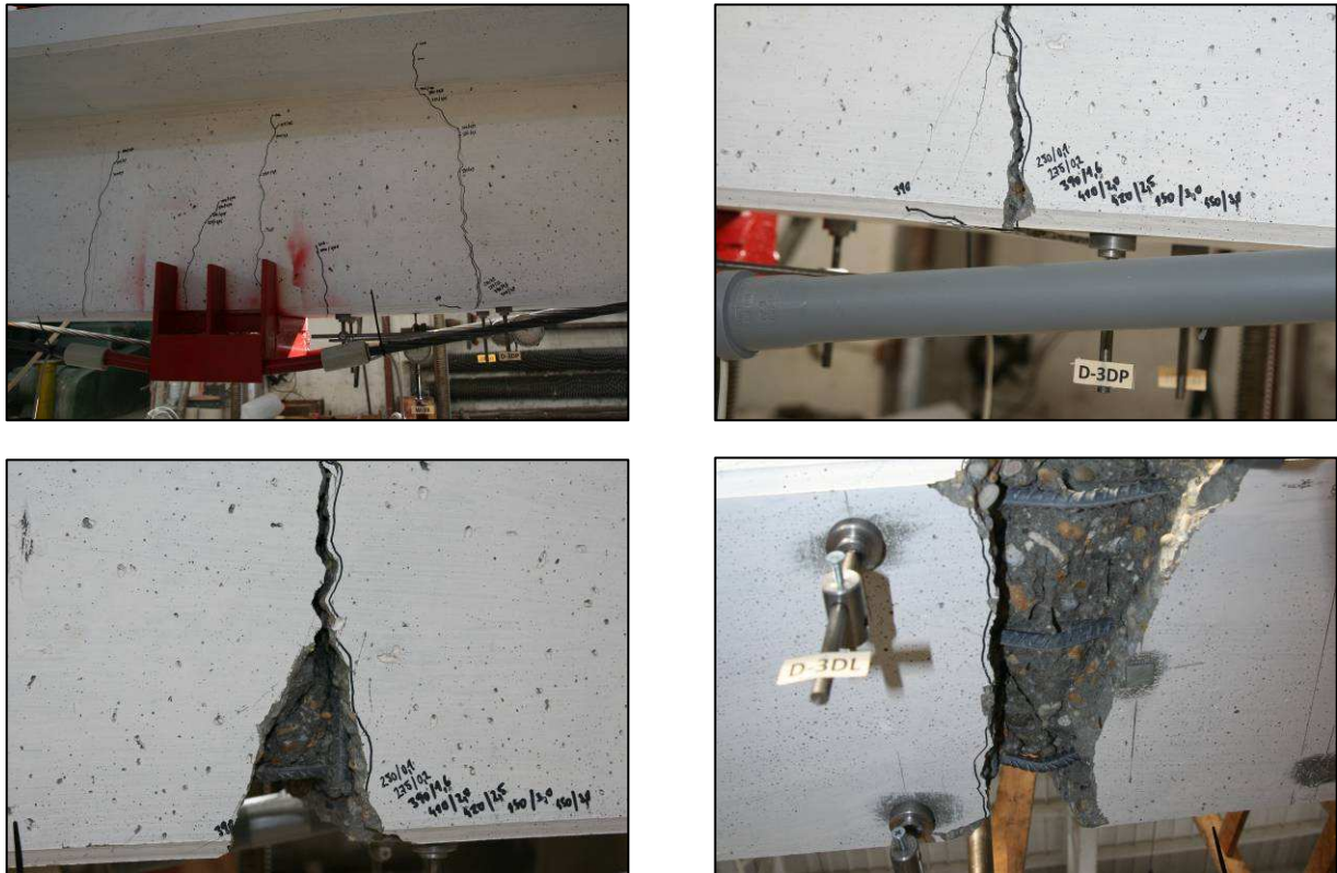
Obr. 12 Porušenie prierezu v strede poľa – spodné vlákna betónu
