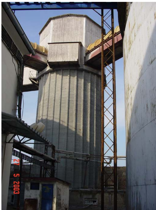
Obr. 2 Celkový pohľad na konštrukciu presýpacej veže
