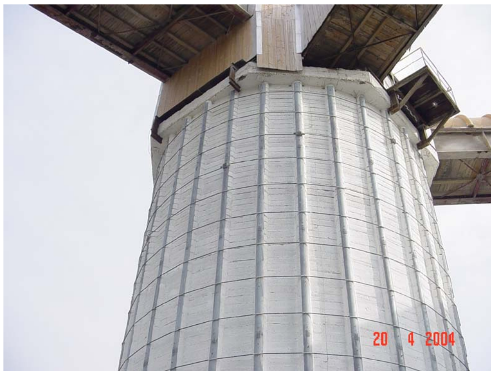
Obr. 5 Pohľad na zrealizované vonkajšie predpätie presýpacej veže.
